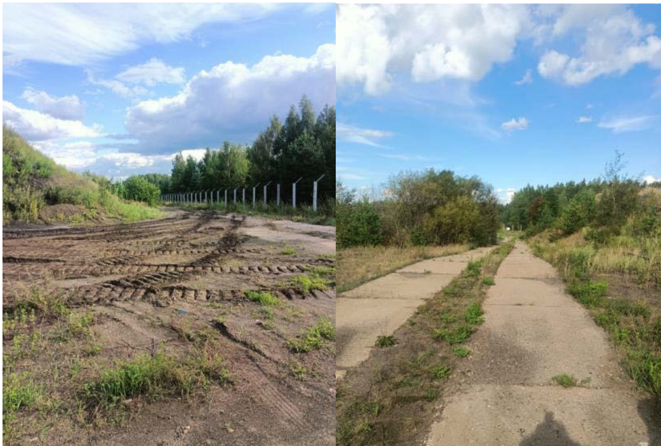
Рисунок 1.1 – Общий вид площадки рекультивации
